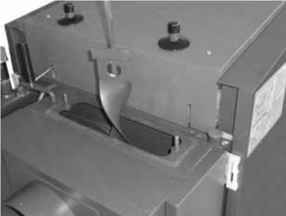
Den Turbulator bei der Reinigung herausnehmen
